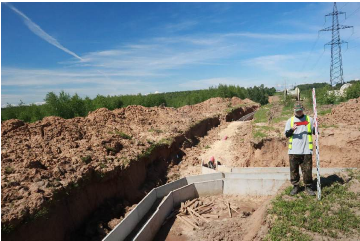
Рис. 23. Обеспечение сохранности ОКН федерального значения «Поселение Ольгинское» в г. Нижний Новгород. 2026 г. Участок проектирования. Точка фотофиксации 2. Вид с В.
